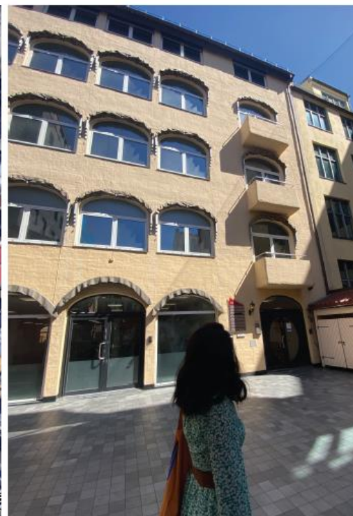
Bygget slik det står i dag.
